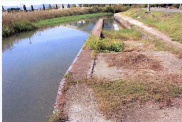
水位が下がって、河口近くに移動したときの山田港（跡）。
